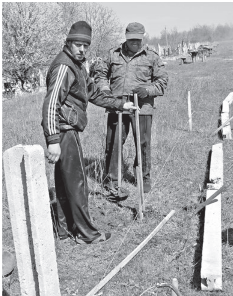
Михайло із односельцем бетонують стовпи по периметру студенянського кладовища. Ті слугуватимуть опорами для майбутнього цвинтарного паркану
