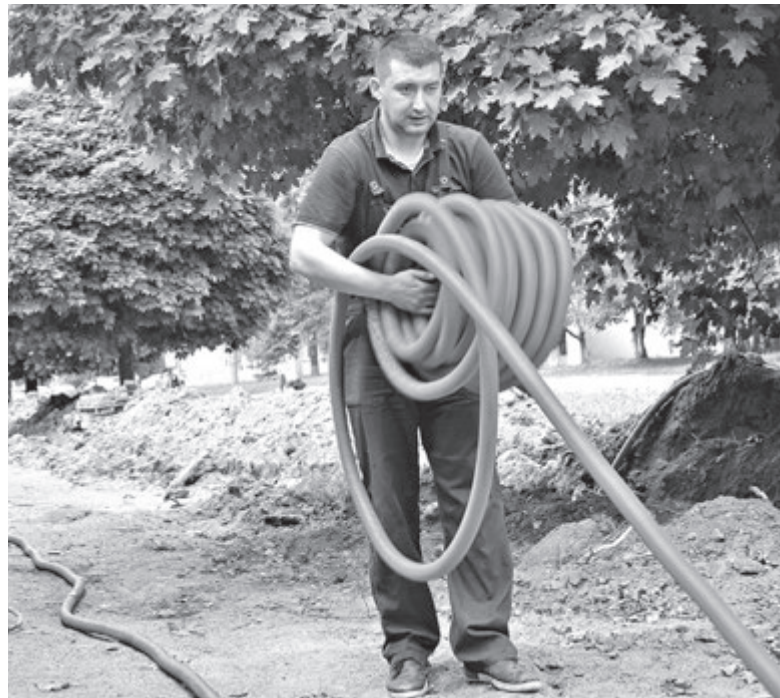
Олександр з товариства «Альфаметрік» розтягує гофру для кабелю живлення. Тут буде кілька кілометрів дротів для освітлення, відеокамер та інших приладів
