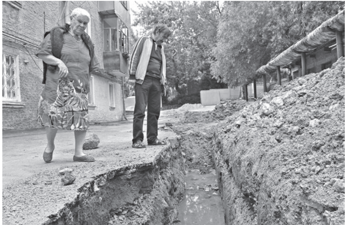
Канаву поряд з багатоповерхівкою була 12 днів. Її розрили комунальники від початку до кінця подвір'я, поряд з входами в два під'їзди
