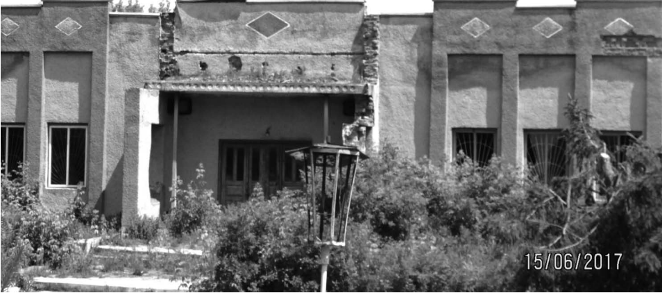
Навпроти сільради занедбане приміщення Будинку культури
