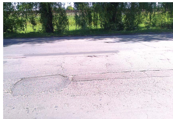
УГАДАЙТЕ, ДЕ НАЙБЛИЖЧИМ ЧАСОМ ТРІСНЕ ДОРОГА
