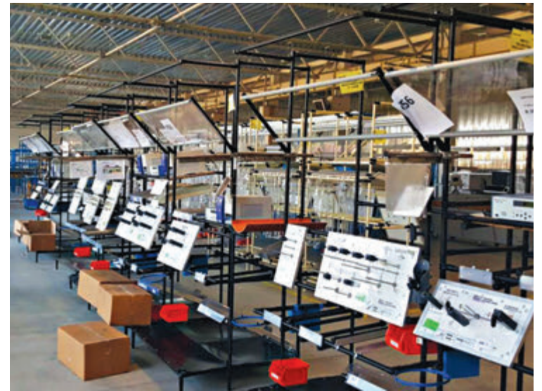
Обладнання першого цеху заводу уже монтують
