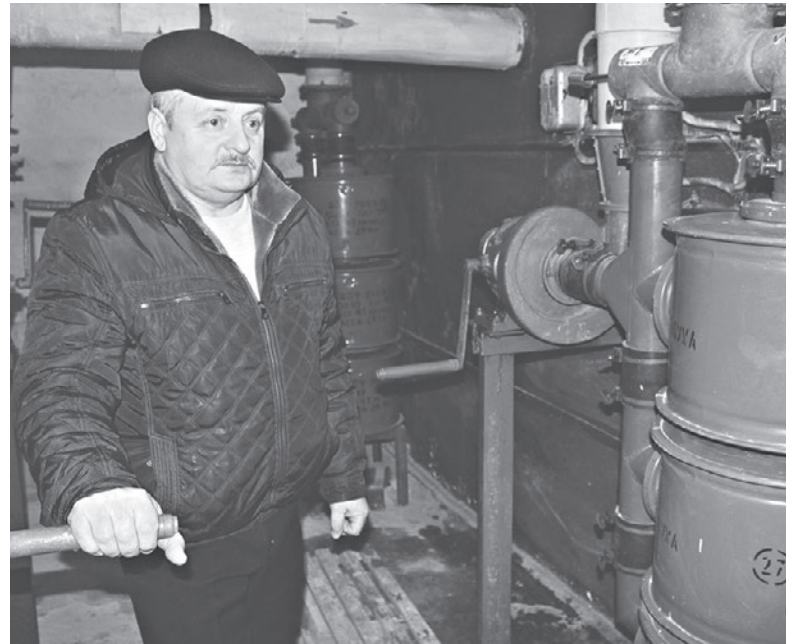
Леоній Каракулько показує, як працюють фільтри повітря у бомбосховищі. На випадок, якщо будуть проблеми із електрикою, у фільтровентиляційної установки є ручний режим
