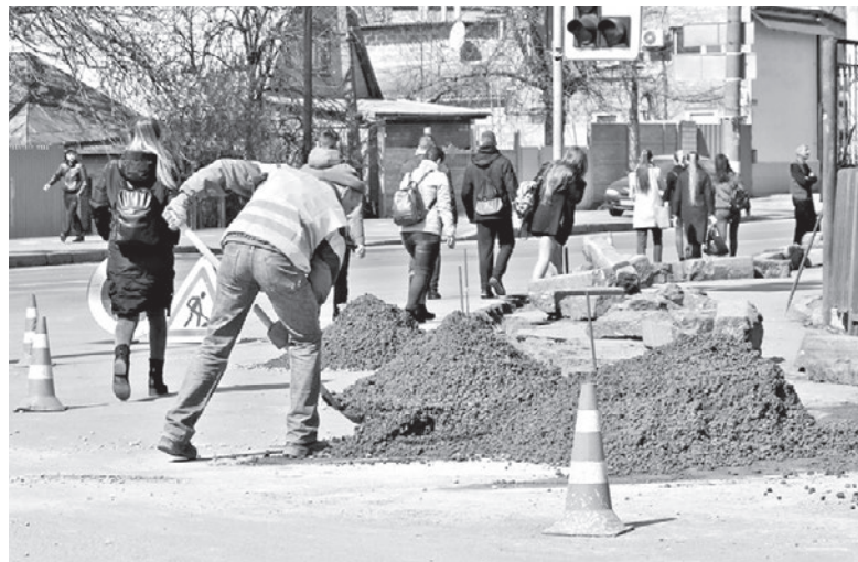
На перехресті Київської та Гонти ремонтують тротуар. Роботи з дорожнім покриттям розпочнуться, як потепліє
