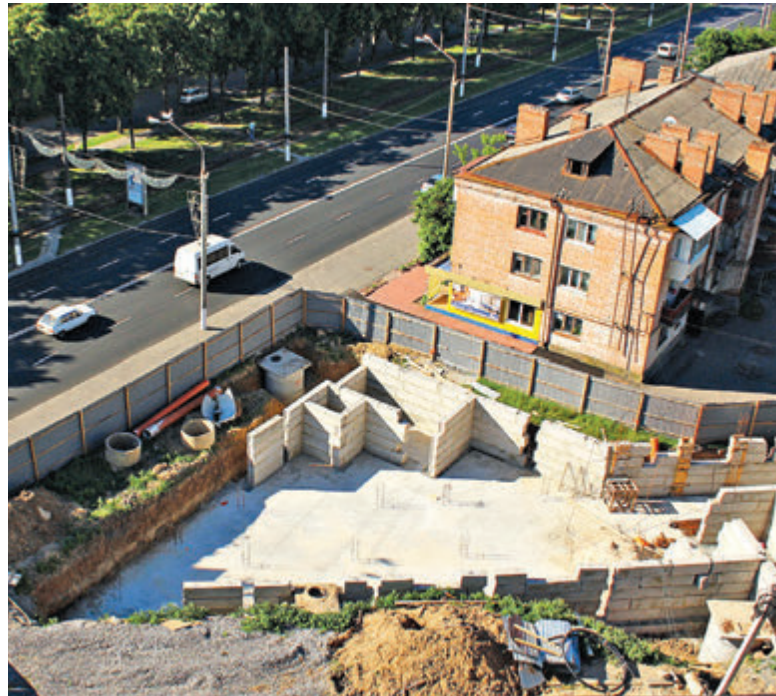
«Мертвий» об'єкт на Пирогова: роботи на будівництві торговельного центру зупинилися, бо бригада поїхала на заробітки за кордон
