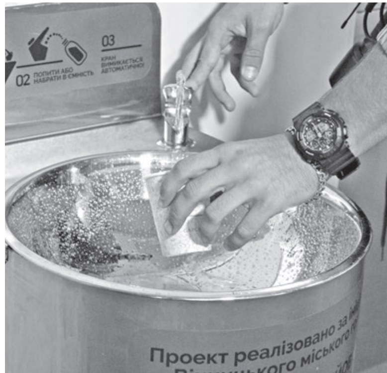
Установки розробили спеціально під вінницьку воду. Вона може очищати до 80 літрів рідини на годину та матиме бак на 200 літрів
