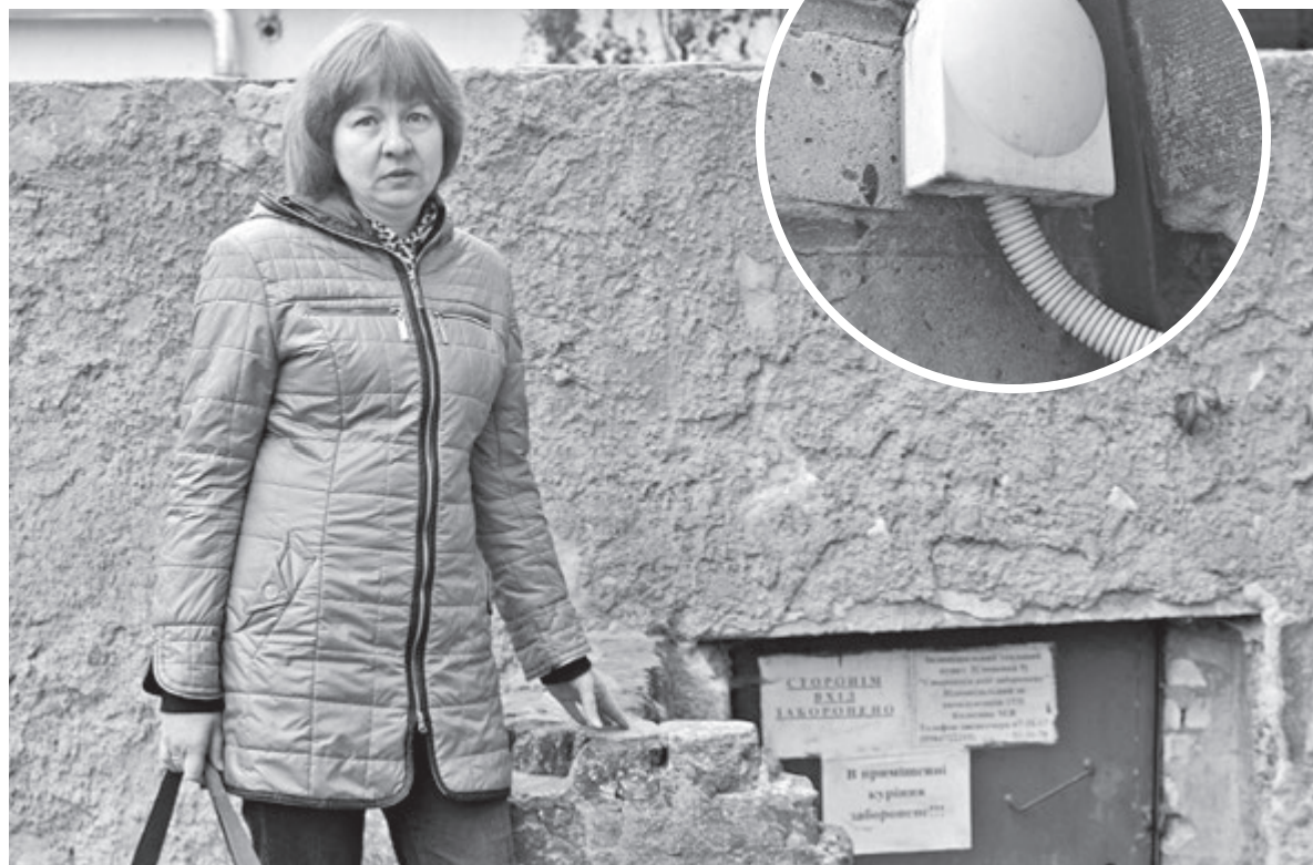
Світлана Андрушко стверджує, що не працює обладнання, яке мало регулювати тепло в будинку. Тепловики запропонували їй регулювати опалення вручну, через шпарину в підвалі
