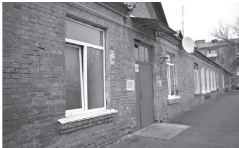
Сьомий будинок в провулку Литовському, хоча й нагадує приватний будинок, але є багатоквартирним
