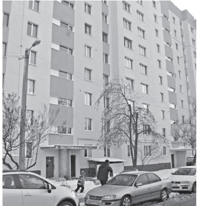
У будинку утеплили стіни, замінили у під'їздах вікна на пластикові. Перед тим навели лад у підвалі
