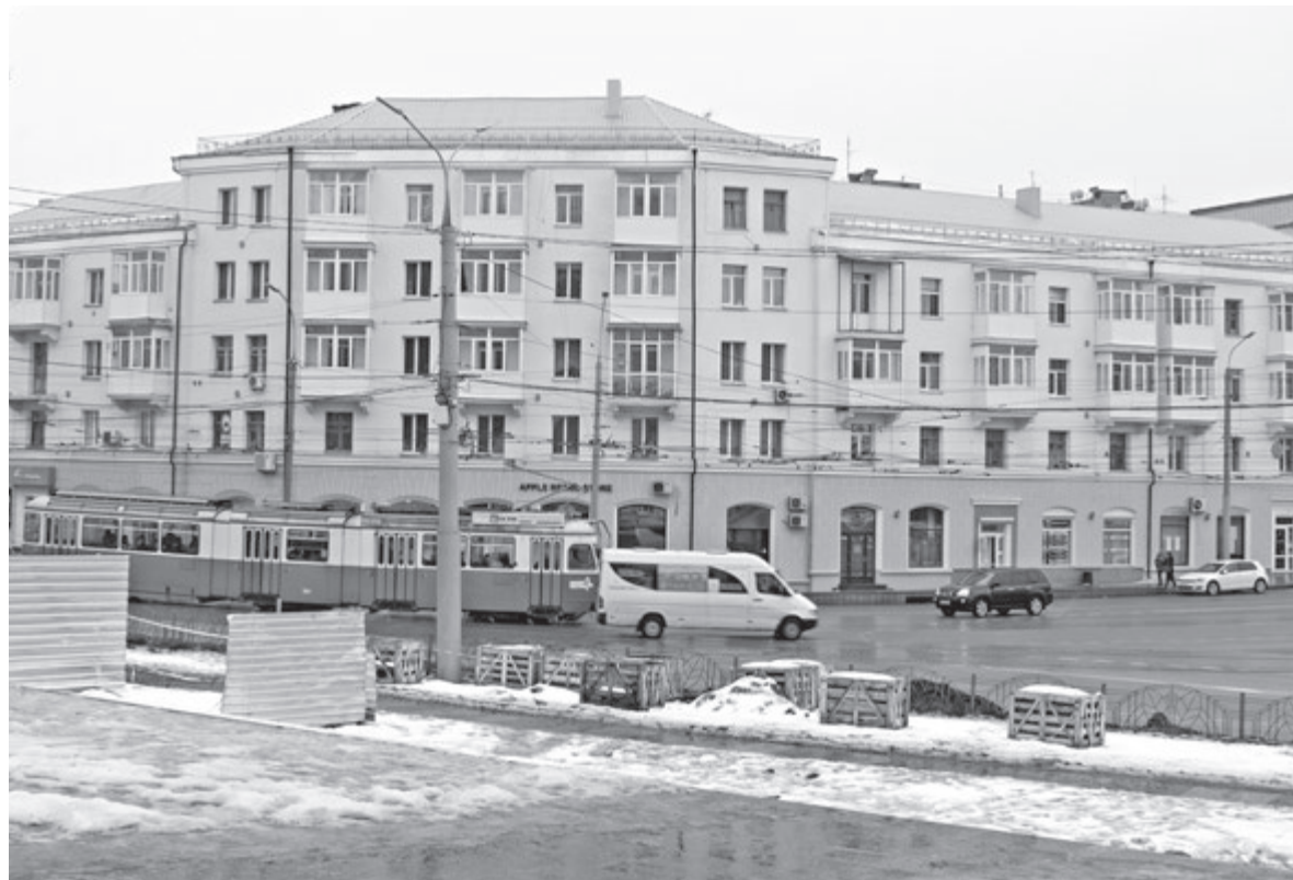
Будинок має утеплений фасад, новий дах та підсвітку. Усе це коштувало понад 5,5 мільйона гривень з бюджету Вінниці
