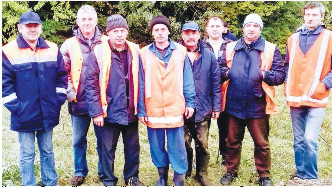
Колектив Дистанції сигналізації та зв'язку під час ремонту кабеля
