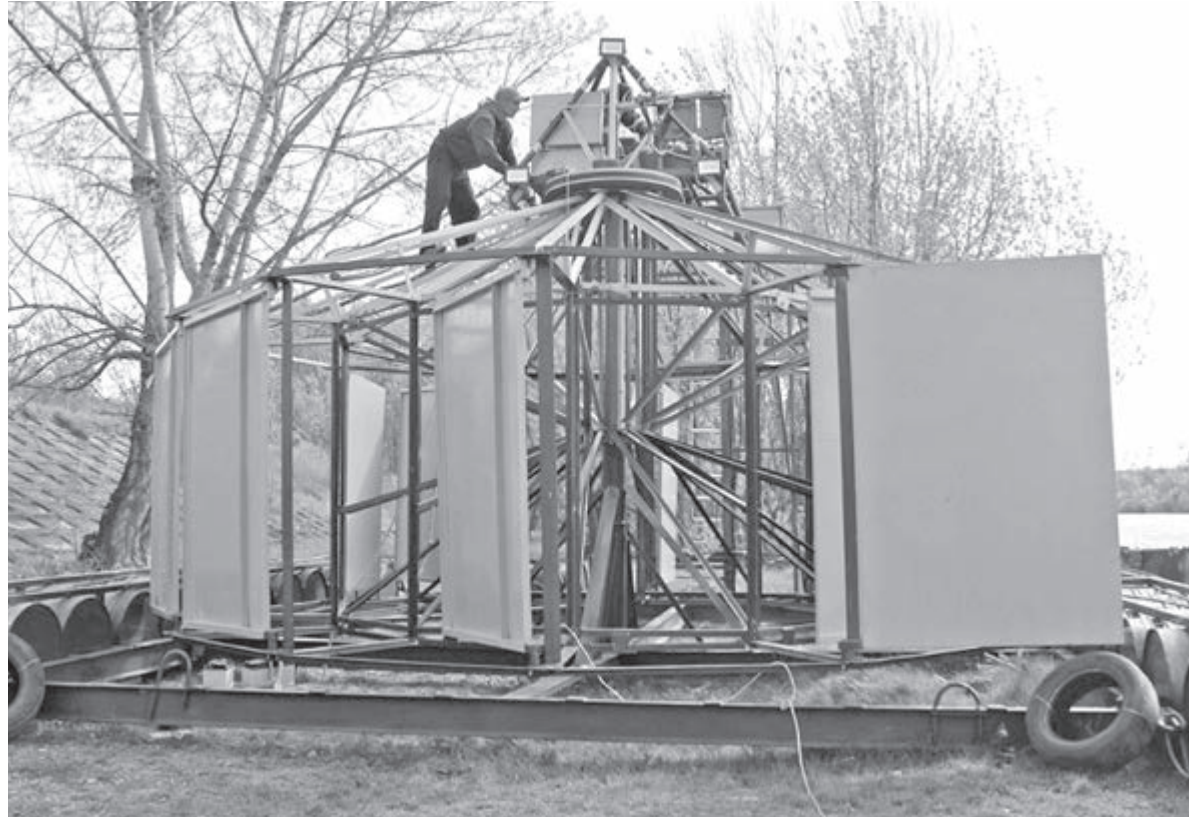
Діаметр колеса дослідного експериментального зразка становив шість метрів. Для постійної станції він має бути збільшений у чотири рази
