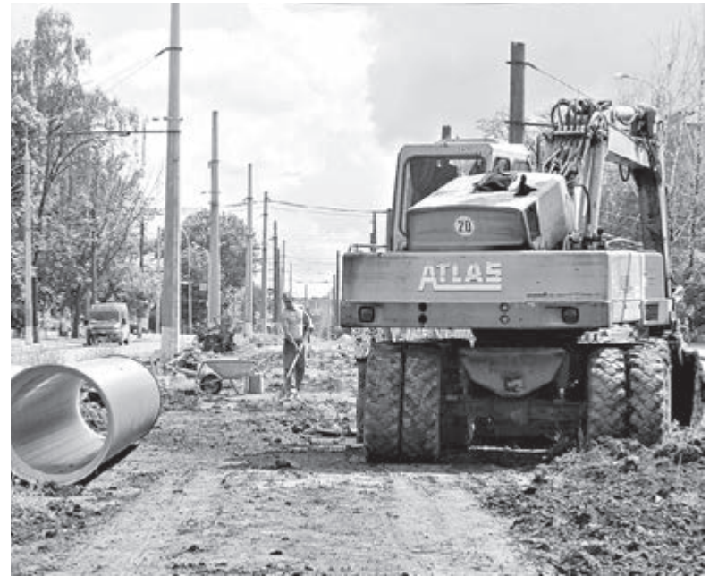
Робітники виконують підготовчі роботи. На алеї вже зрізали дерева, старі комунікації та готуються до старту реконструкції
