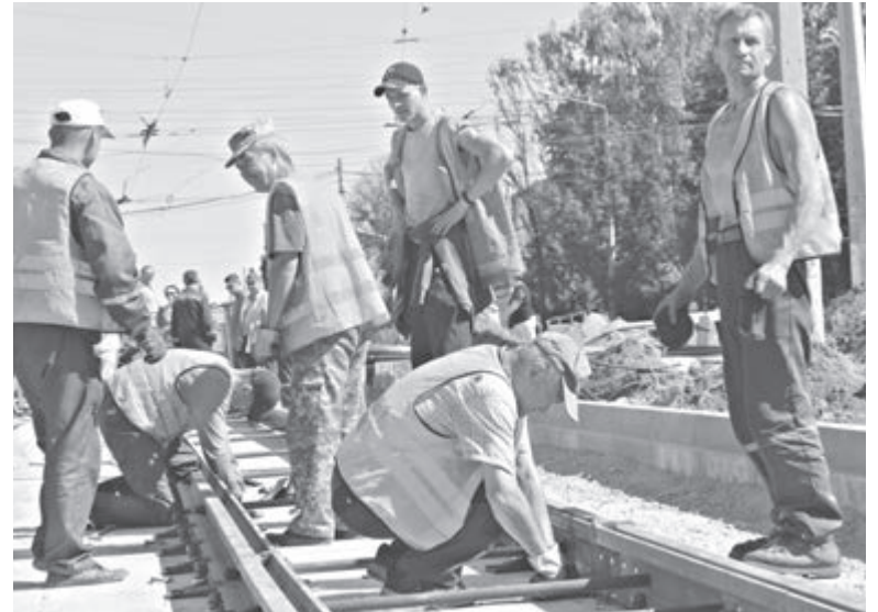
У мерії хочуть завершити реконструкцію до 7 вересня. Довжина відремонтованої вулиці складає 1 кілометр, а загальна вартість — понад 160 мільйонів гривень
