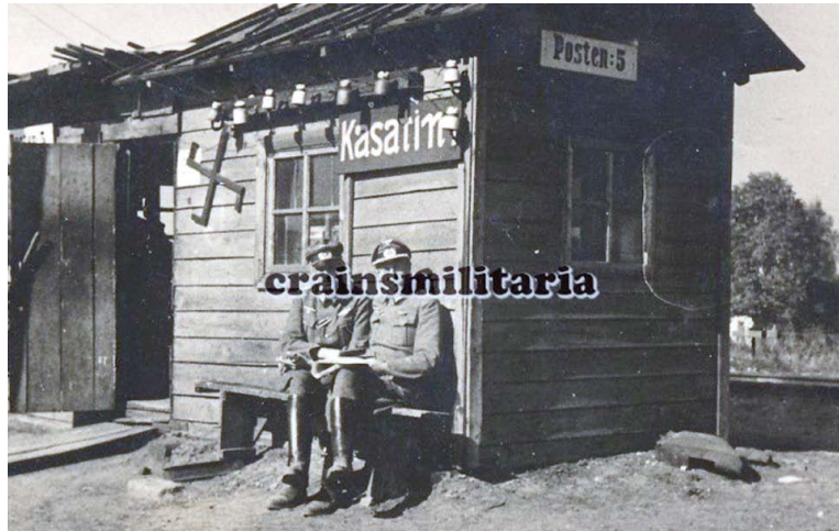
Пост №5 на станції Козятин
