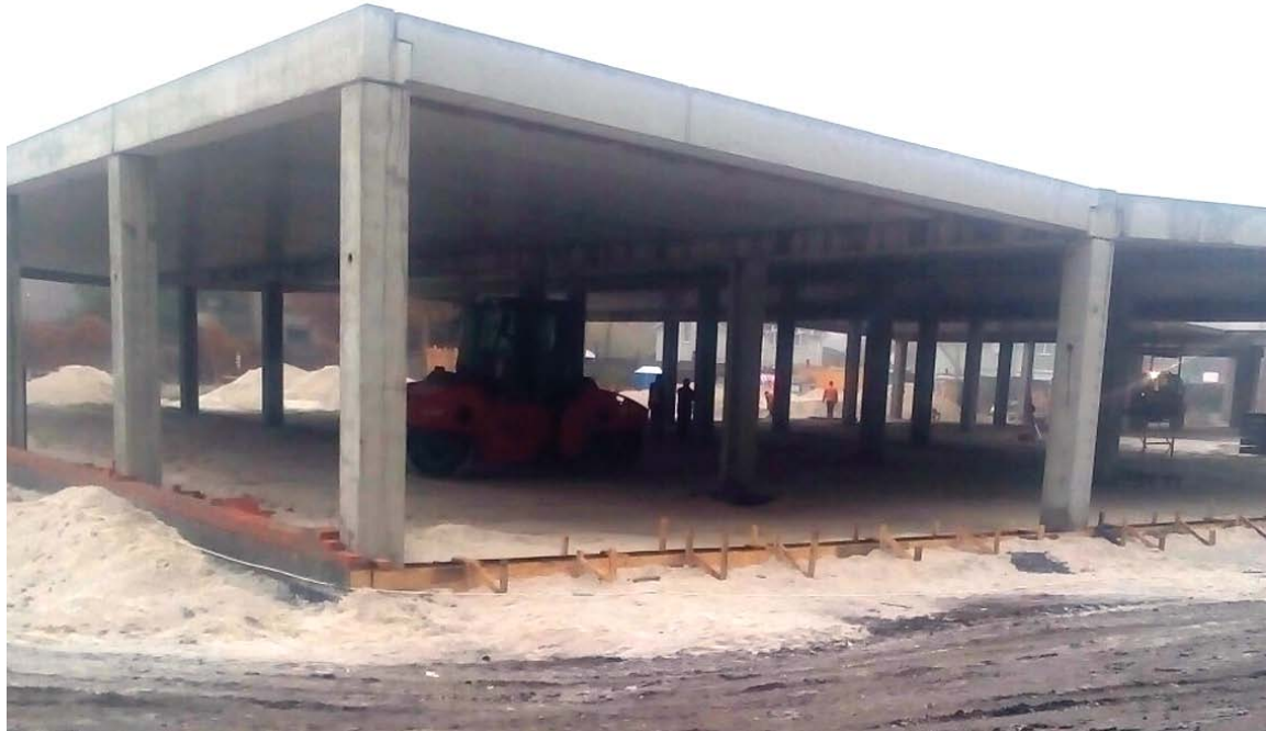
За місяць з пустиря вивезли старі конструкції, очистили рештки старого фундаменту та перезалили його
