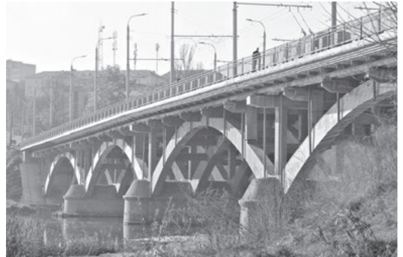
Від Київського мосту прибрали всю будівельну техніку. Останні півроку там стояли вагончики будівельників і автокран
