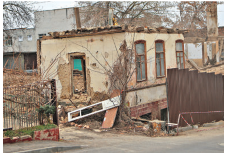
Будинок зруйнували за декілька хвилин. Екскаватор розніс ковшем залишки стін та фасаду двоповерхівки
