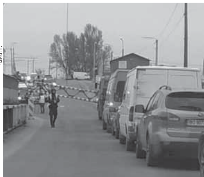
Обмежувач через чисельні ДТП погнутий в кількох місцях. Після чергового пошкодження його зняли
