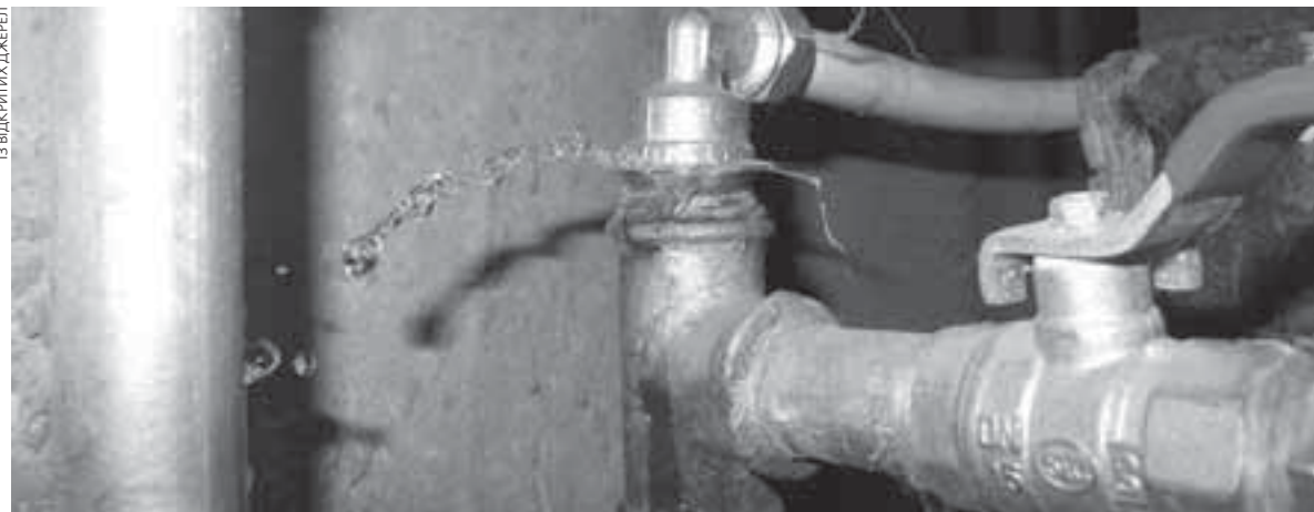
До 17:15 аварійні проблеми у будинку може вирішити ваше обслуговуюче підприємство. Після — аварійні служби
