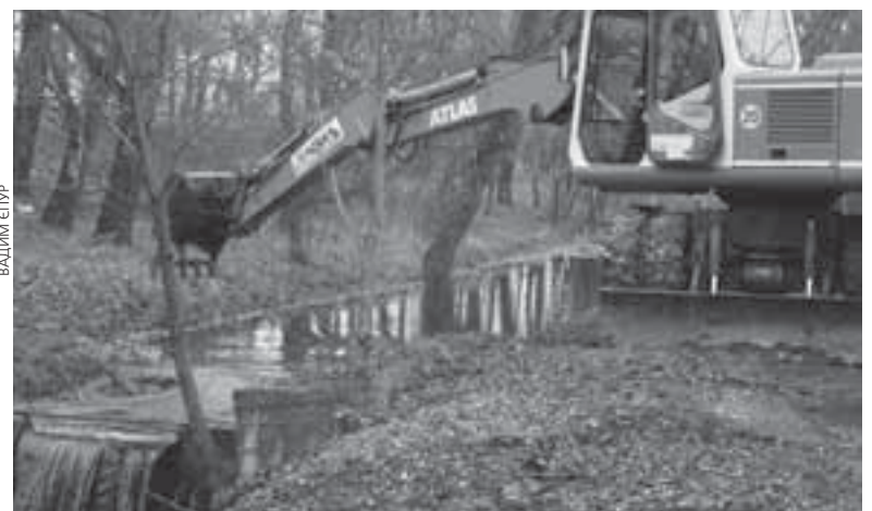
Для того щоб очистити водні канали працює кілька одиниць техніки. Мул та сміття дістають екскаватором
