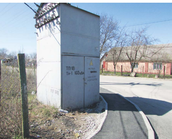
Електрики зі стажем кажуть загородити трансформатор буде не зайвим
