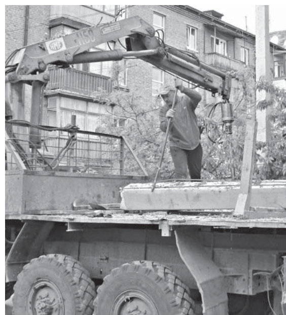
На ПРБ енергетики замінюють опори ЕЛ
