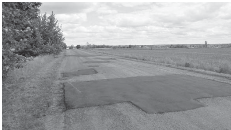
На початку травня цього року дорогу «Рубаним» стали ремонтувати
