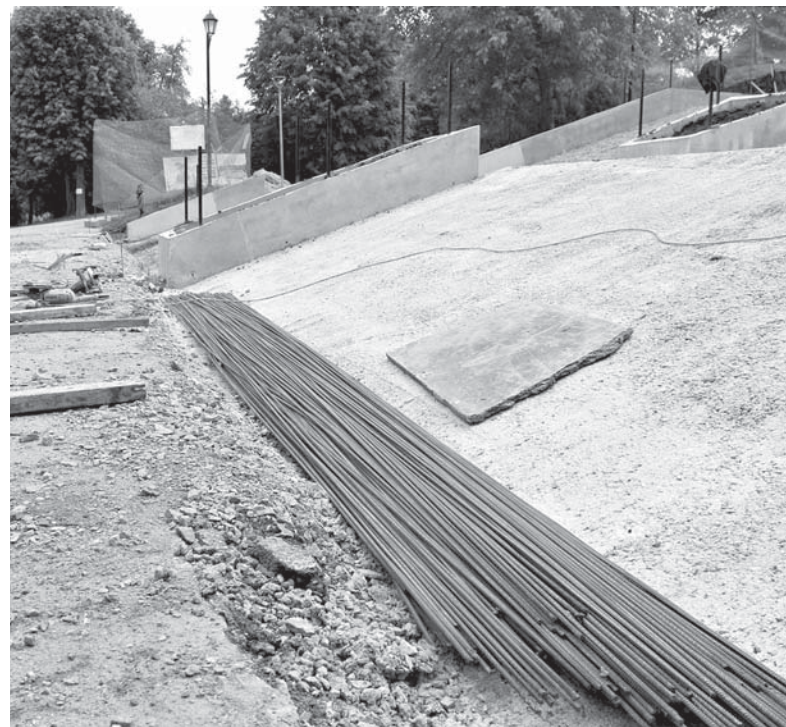
Ремонт сходів обіцяють закінчити до вересня, якщо дозволить погода
