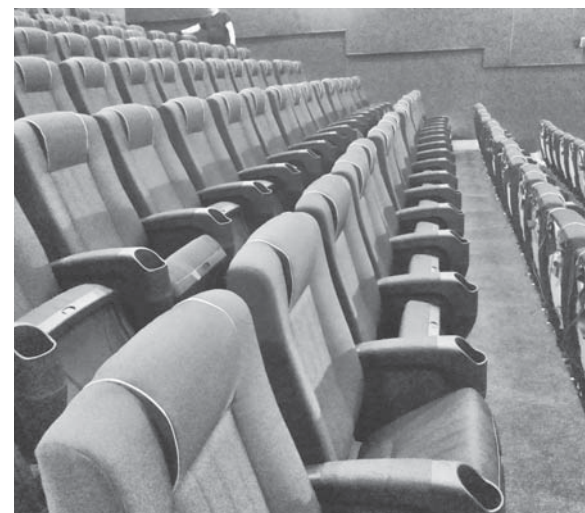
Деякі ремонтні роботи станом на кінець червня ще не завершені, наприклад, монтаж задньої сторони крісел
