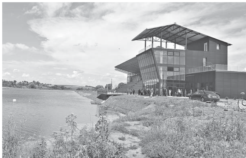
На «Водній арені» тривають роботи. Робітники почали облаштування приміщень
