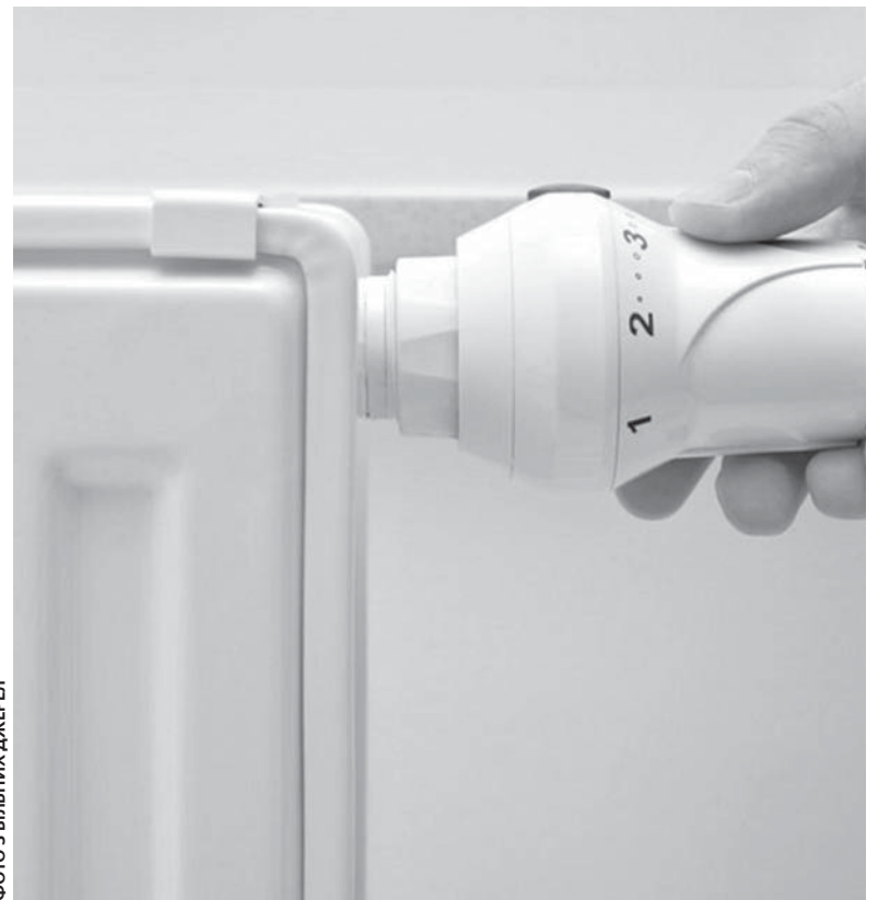
У Тернополі у понад 60 багатоквартирних будинках мешканці можуть підключити індивідуальне опалення
