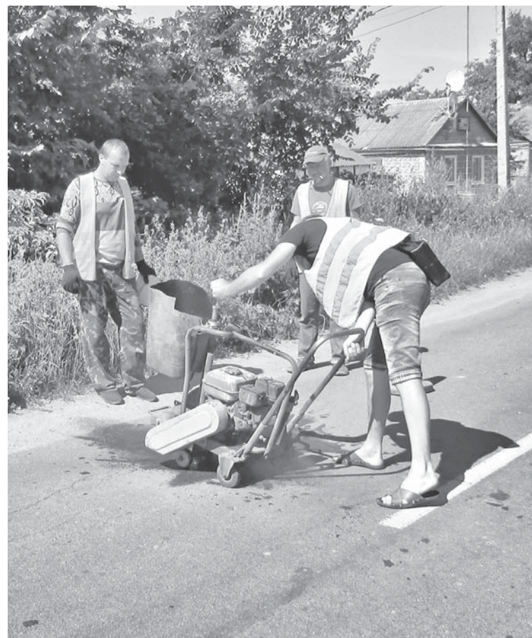
Ямковий ремонт на вулиці Червона Калина. Дорожники випилюють асфальт і поливають фрезу водою
