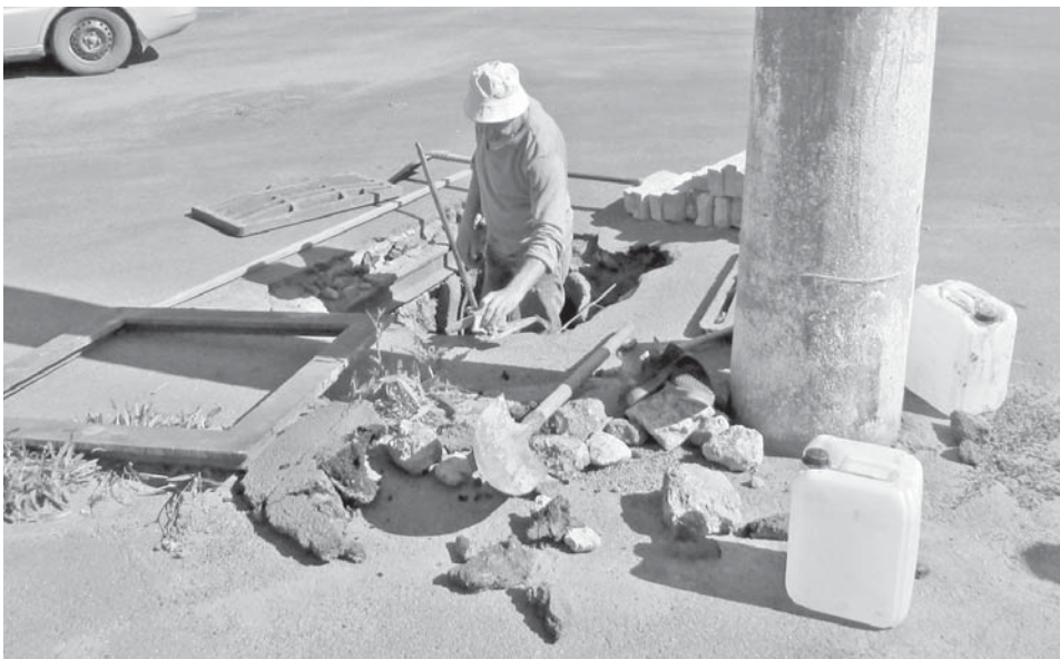
Ремонт колодязя стічних вод на перехресті вулиці Незалежності та Пилипа Орлика
