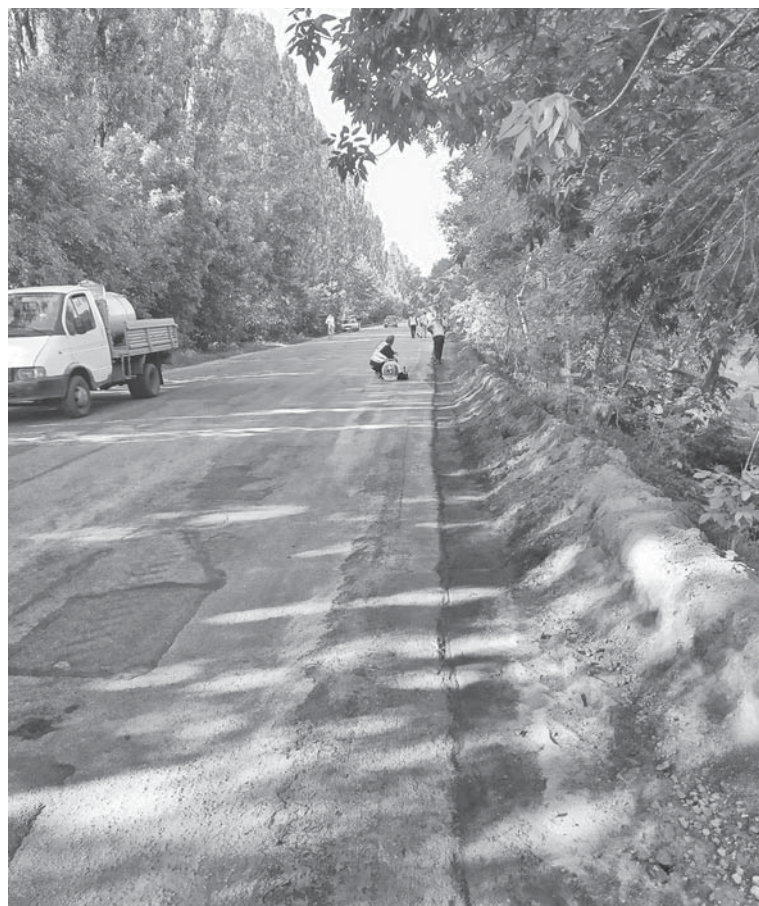
До ремонту безпосередньо мосту справа ще не дійшла. Нині дорожники роблять дорогу через Титусівку
