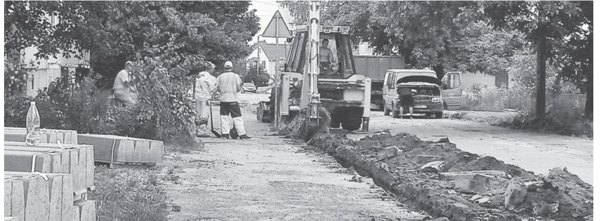
На вулиці Підгорбунського робота кипить. Тут нарешті почали робити капремонт асфальту
