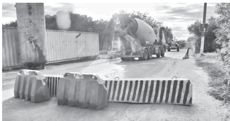
Цей бетоновоз був останнім, який проїхав до закриття мосту на ремонт
