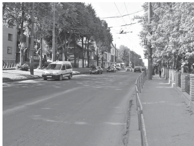
Вулицю Тарнавського під час ремонту повністю не перекриватимуть, транспорт має курсувати
