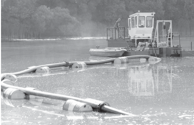
Спецтехнікою очищують дно ріки на глибині понад 2 метри. Якість води має поліпшитися
