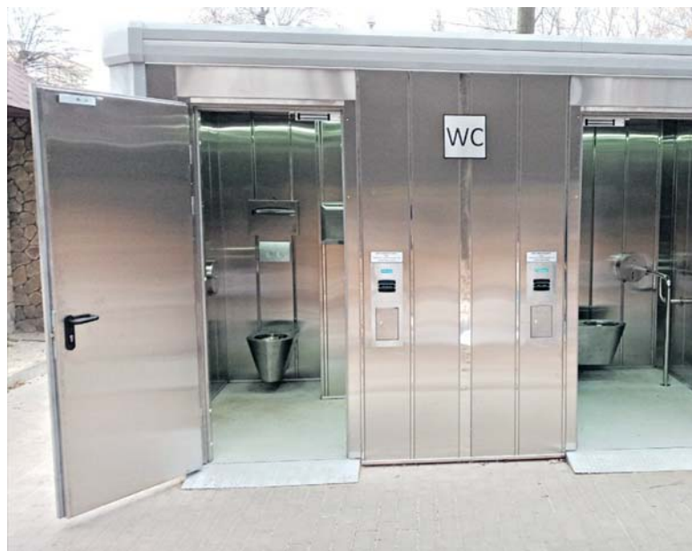
Більше 60% від суми — це прокладання труб та електрики. Сама ж модульна вбиральня коштує близько 700 тисяч гривень
