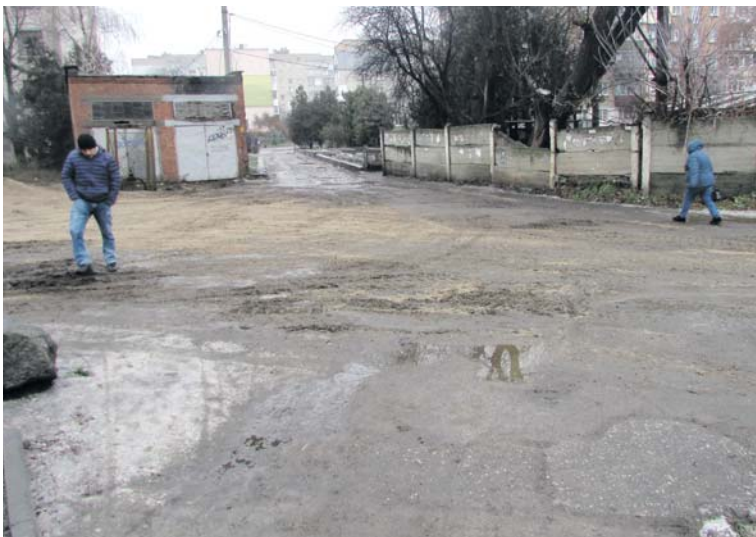
Гірше за ожеледицю може бути тільки багнюка. Це біля котельні ЦРЛ
