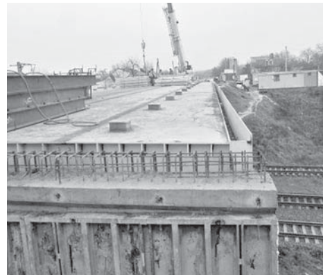
Нарешті ремонтують Білоцерківський міст. Робота кипить
