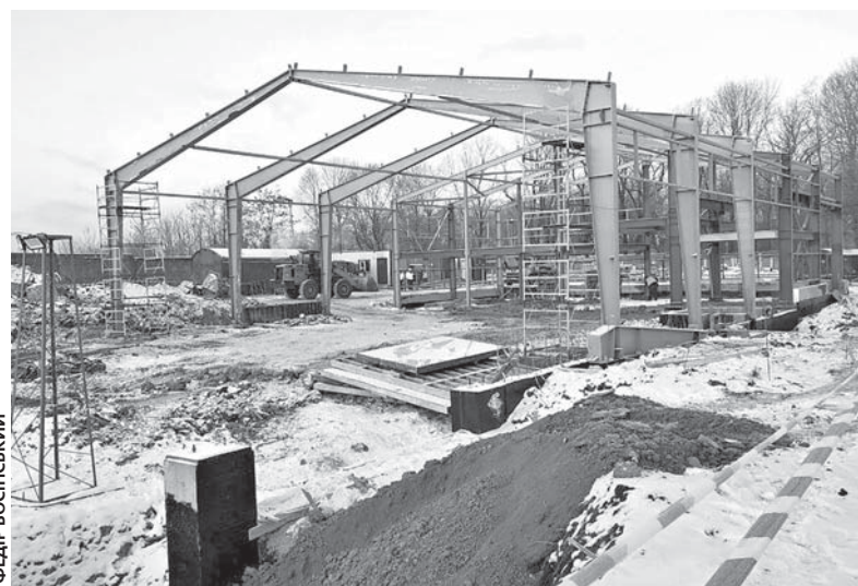
До Водохреща підрядники вже завершили роботу із заливки фундаменту та змонтували каркас самої станції знезалізнення. Ось так це виглядає
