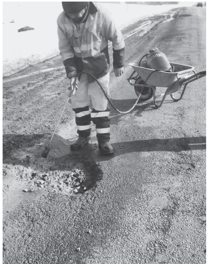
Під час ліквідації аварійної ямковості, дорожники ремонтують ями, які можуть стати на заваді безпечному руху транспорту, наголошують вони
