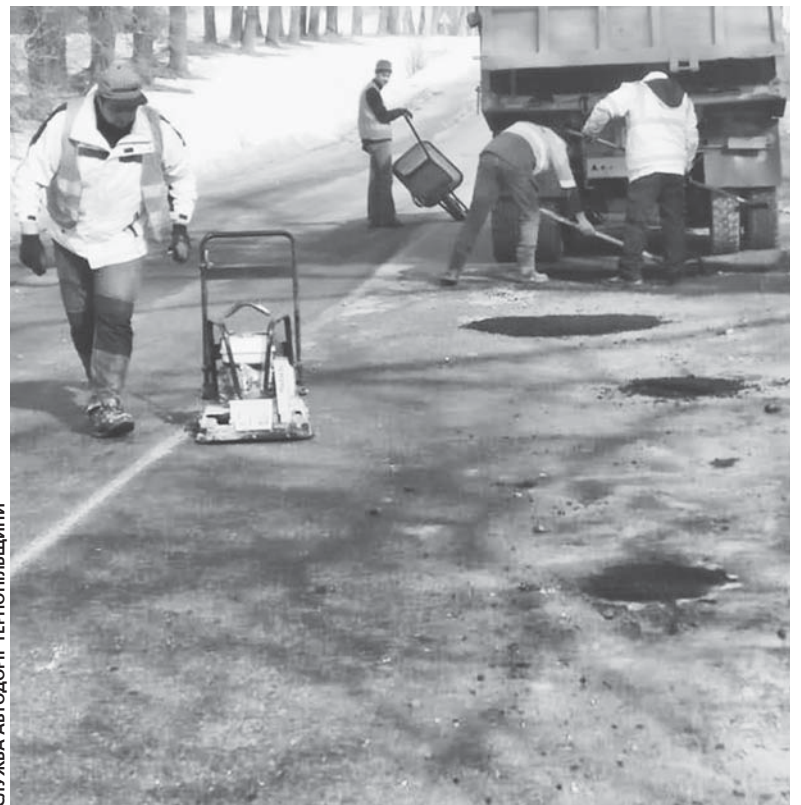
У холодну пору, як зараз, дорожники ліквідовують пошкодження холодним асфальтобетоном, щебеневопопашаною та іншими бітумно-мінеральними сумішами. Однак такий ремонт є тимчасовим
