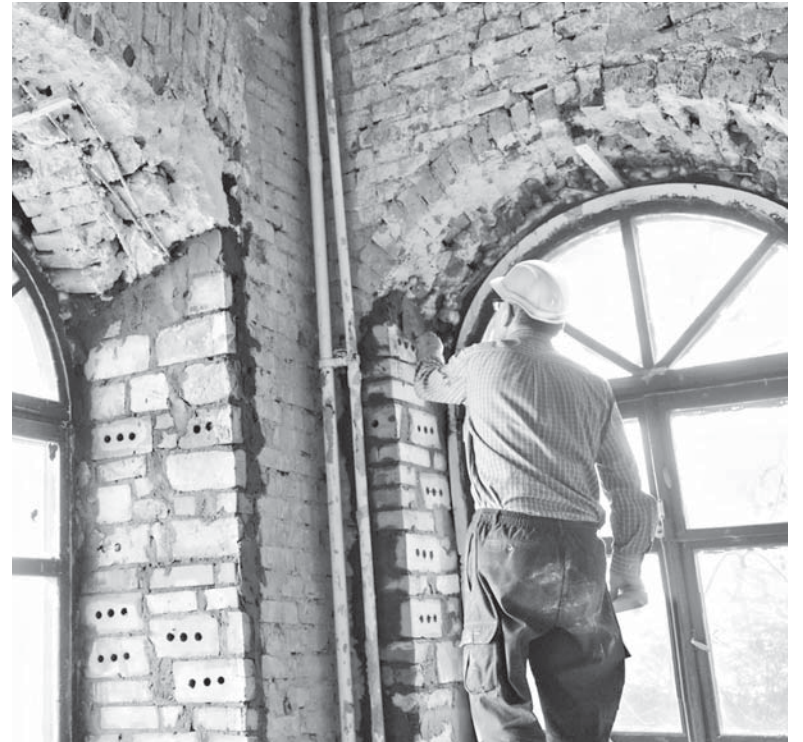
Будівельники зараз виконують демонтажні роботи. До кінця року вони мають перекрити дах і зробити вогнезахист дерев'яних конструкцій
