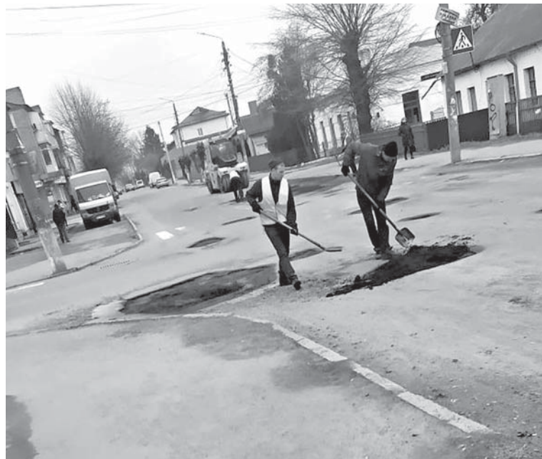
Почали проводити «ямковий» ремонт.
