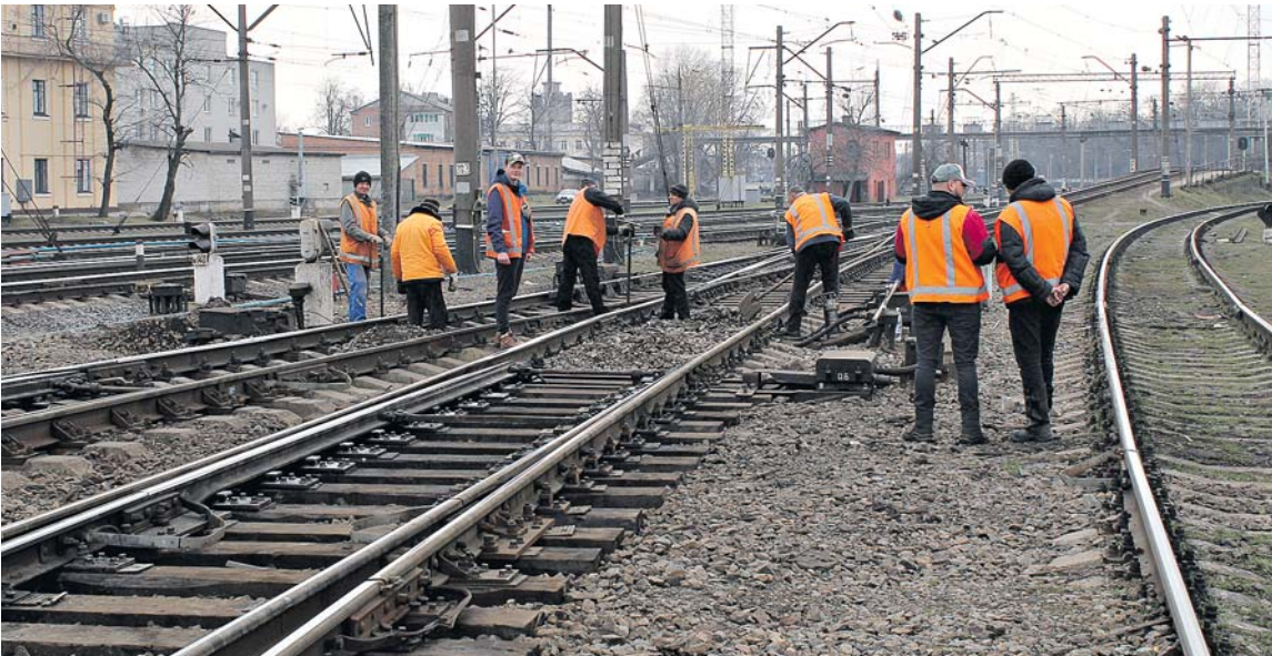
У залізничників завжди робота є. Звичайні будні — ремонт колії
