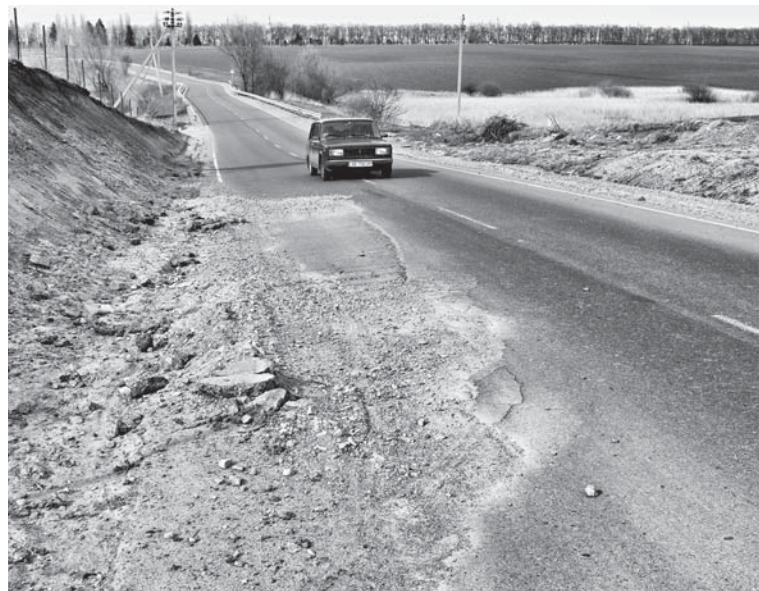
На об'їзній частині дороги не витримала навіть півроку. Її тут вже неодноразово латали
