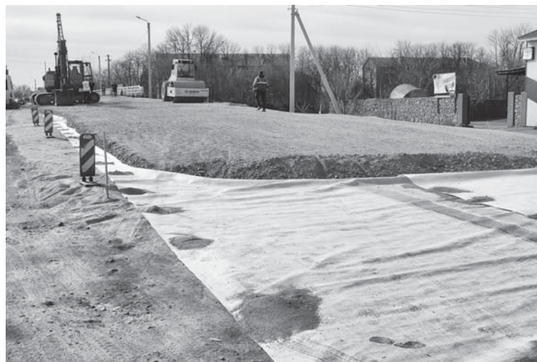
Біля мосту під щебінь стелять текстиль. Роблять це для того, щоб дорожнє полотно довго служило
