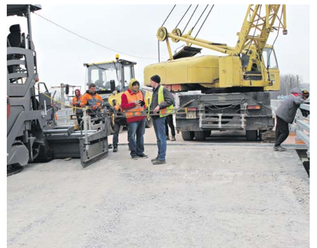
Ремонт Білоцерківського мосту на завершальному етапі. Нині тут кипить робота
