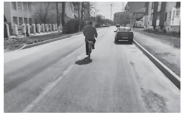
Відремонтована вулиця Підгорбунського.
