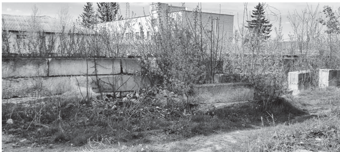
Довгобуд вже весь поріс чагарниками. Це будівництво заморозили ще у 90-их
