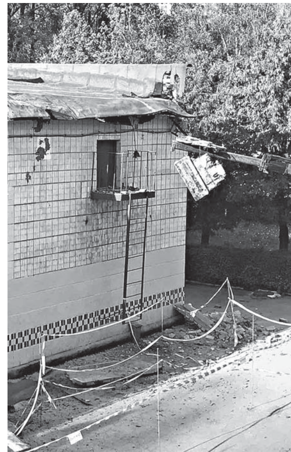
В мерії запевнили, що це не обвал даху. Бетонні плити збивали будівельники, а капремонт покрівлі буде вже у цьому році
