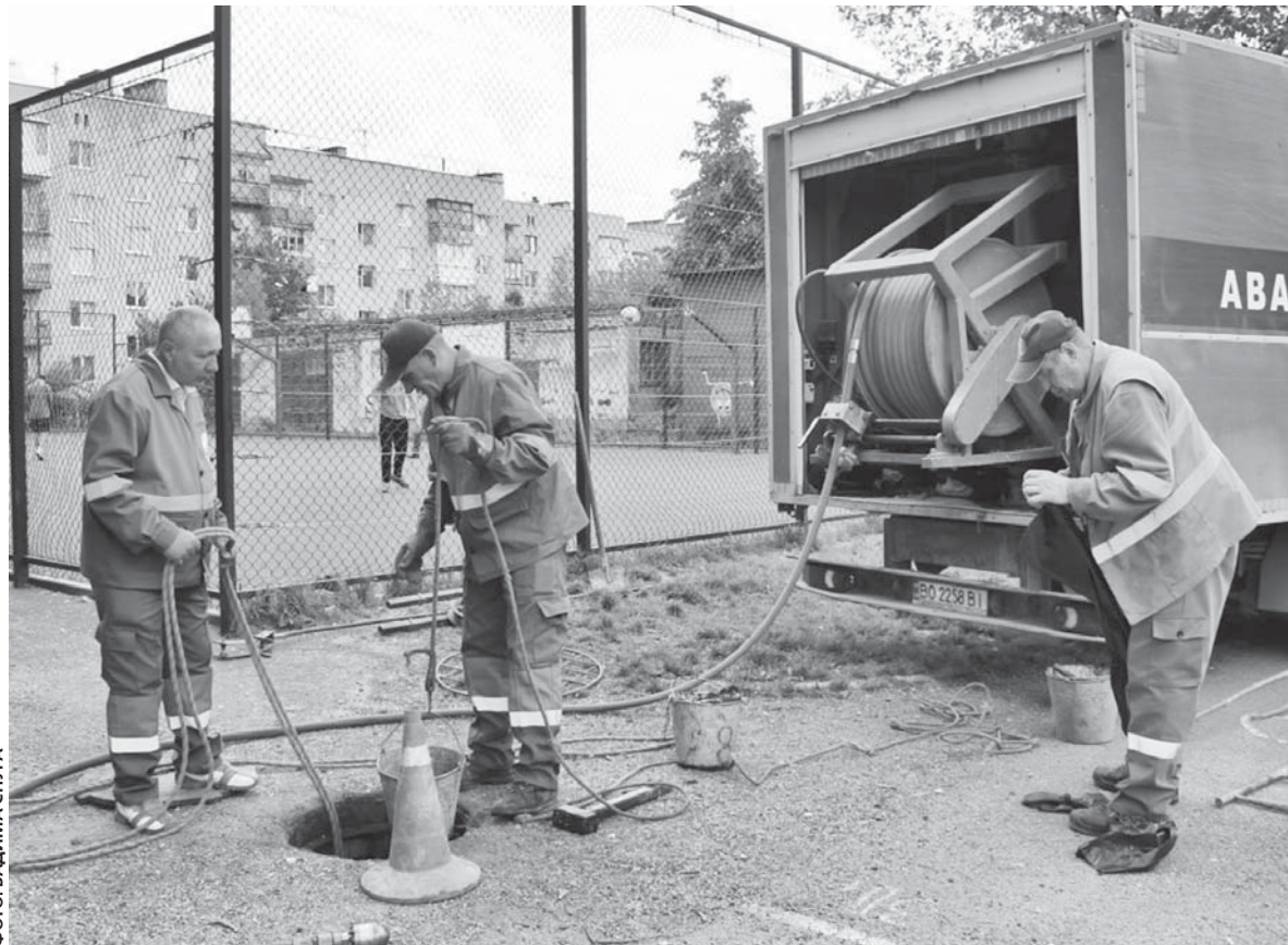
Бригада аварійників «Водоканалу» під час виклику в школу №2
