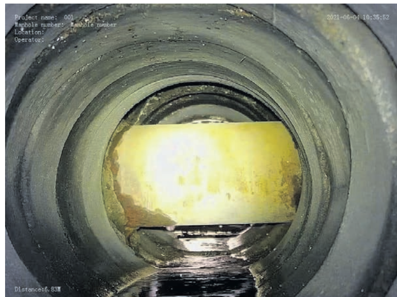
Труба, яка, за версією Сергія Сухомлина, перекрила зливовий колектор
