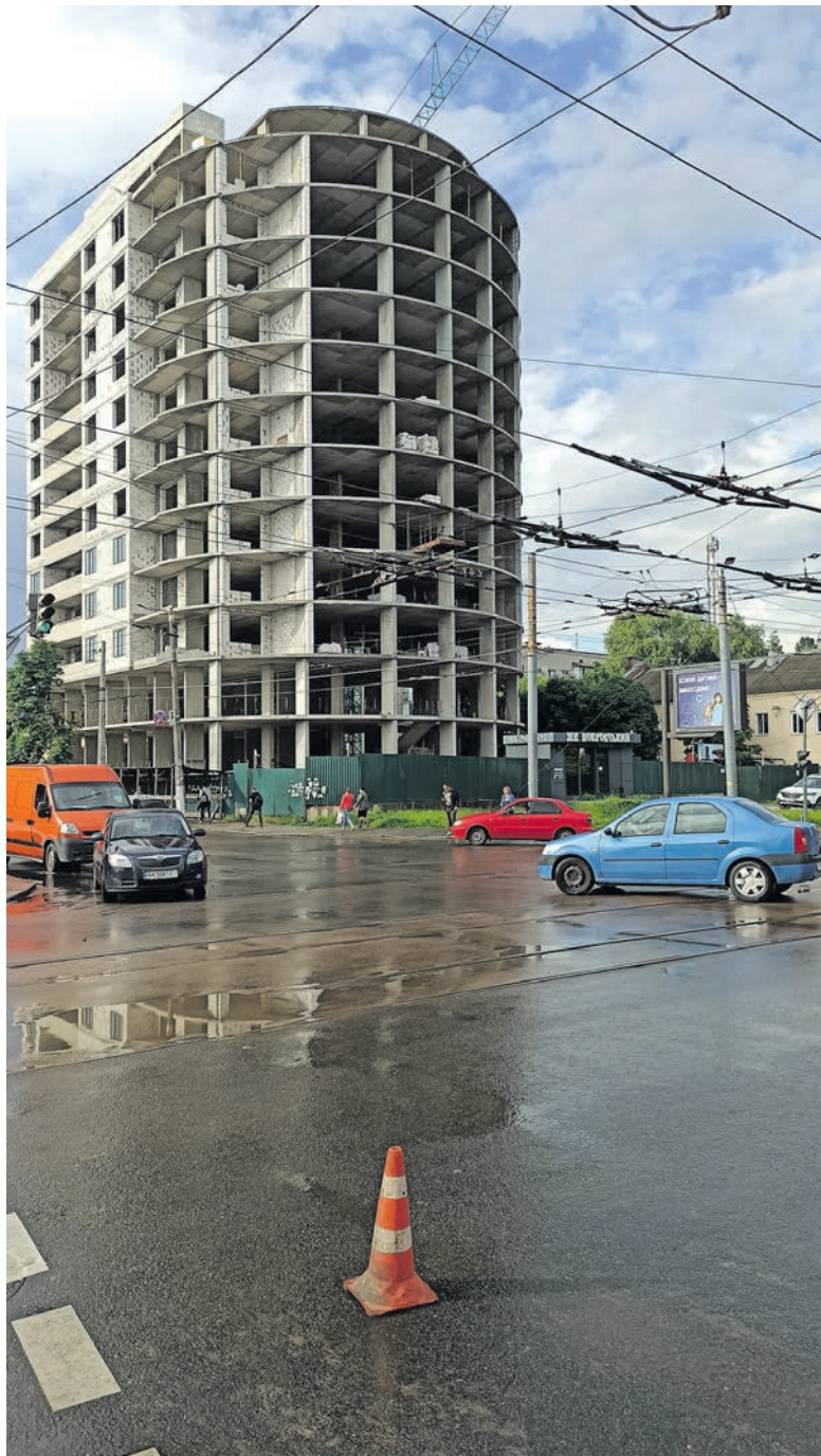
13-поверховий будинок стоїть прямо на інженерних комуналіціях
