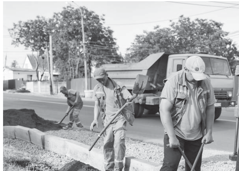
Робітники встановлюють нові бордюри на вулиці Данила Нечая. Генпідрядник ремонту — вінницьке товариство «Шляхбуд»
