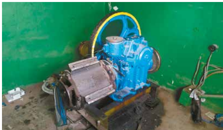
Цей мотор піднімає і опускає «серце» багатоповерхівки
